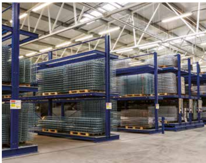
◀ Modernes, flexibles Lager-Regalsystem des Logistikzentrums in Uhřetice.
