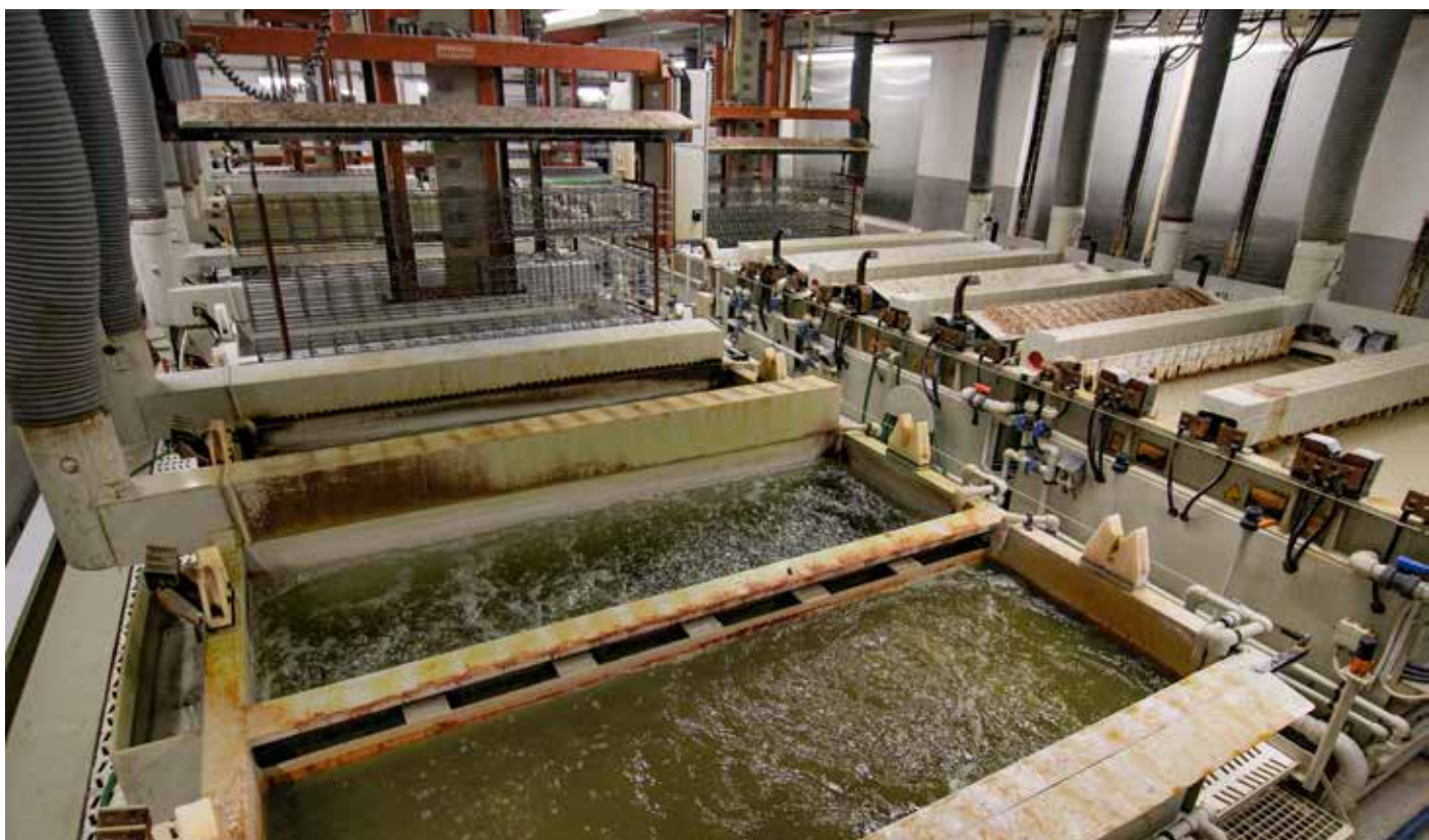
▲ Anlage des galvanischen Verzinkens im Produktionsareal in Uhřice.
